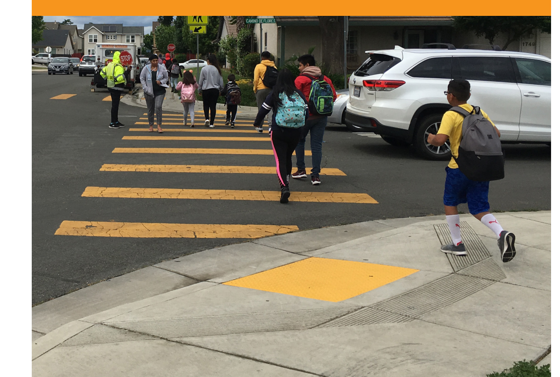
ADA CURB RAMPS
